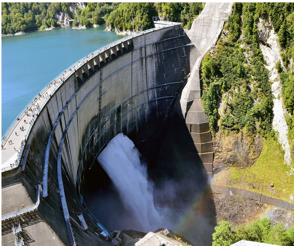
Barrage hydraulique ou hydro-électrique
